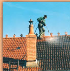
Nettoyage, démoussage et hydrofugation, sur terre cuite, et tuiles ardoises fibres-ciment
